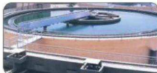
شكل (٦٢) محطة لمعالجة مياه الصرف الصحي
