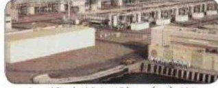
شكل (٥٧) محطة لتحلية المياه في الجبيل
