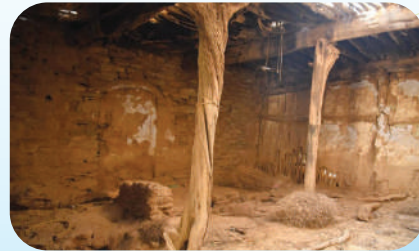
مسجد تاريخي قبل ترميمه
