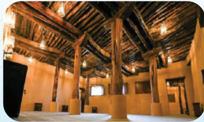
مسجد تاريخي بعد ترميمه
