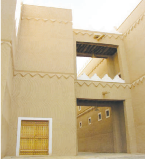
الشكل (٢) البيوت الشعبية في منطقة المربع بالرياض
